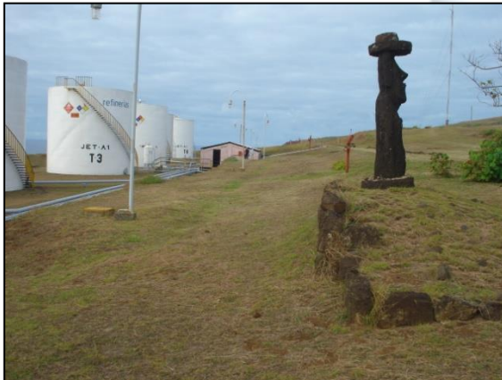
Terminal VINAPU – Enap refinerías Aconcagua (Isla de Pascua)
