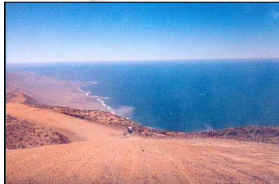
Gasoducto Mejillones-Paposo 12" Y 16" en dos Tramos (Gasoducto Taltal)
